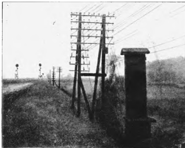
Fig. 3. Smoorspoelen-inbouw bij Spandau.
